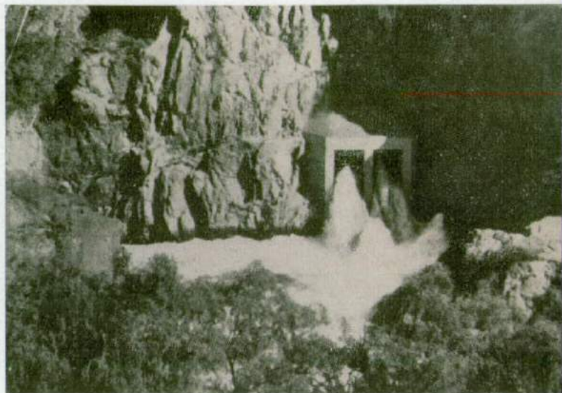
Galleria di deviazione provvisoria del Rio Mantaro.
