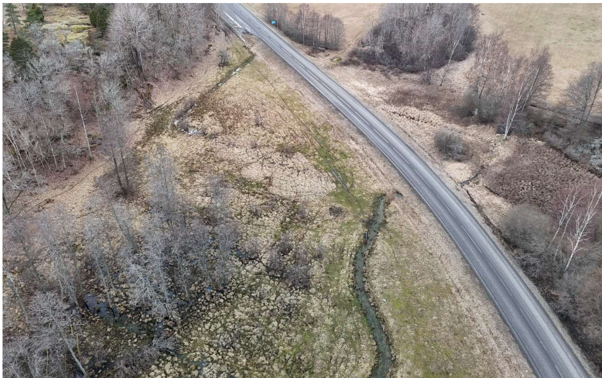
Flygbild över områdets övre delar, där inkommande stordike syns tydligt. Foto Sören Eriksson.
