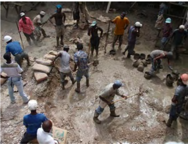
En haut à gauche - la préparation du béton pour la deuxième toit. En haut à droite - Inscrivez-vous sur le site du Rotary.
