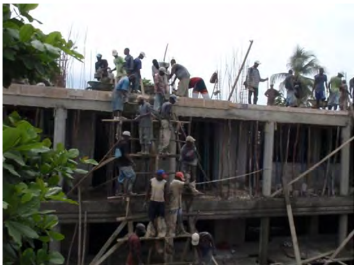
À gauche - des travailleurs ajoutant concrètes pour la deuxième toit.
